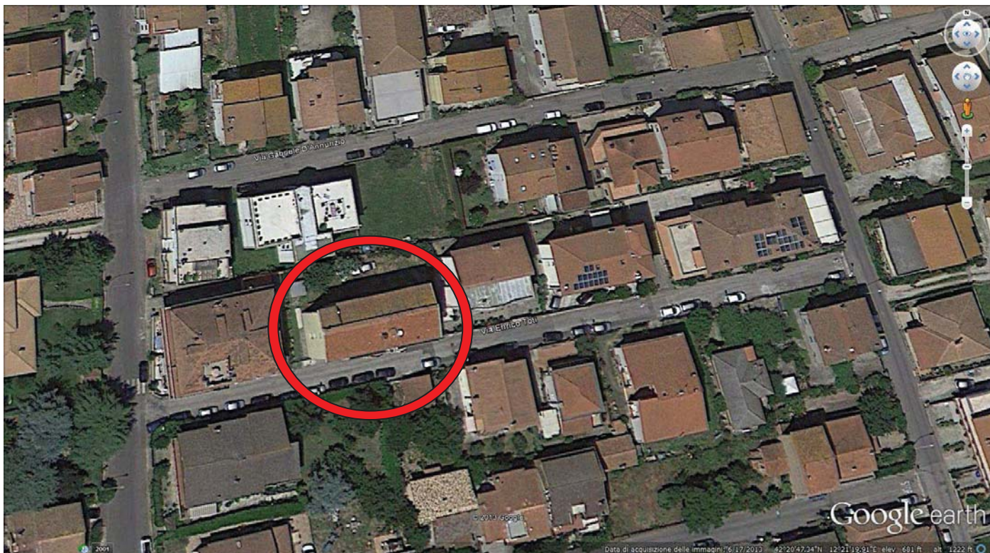
Vista aerea del fabbricato in Corchiano Via E, Toti n.° 5
