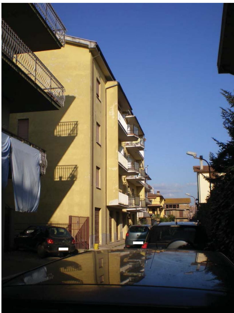
Vista laterale sinistra del fabbricato da Via E. Toti.
