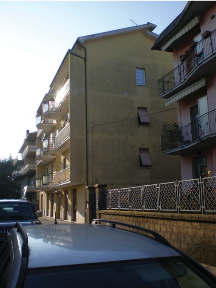
Vista laterale destra del fabbricato da Via E. Toti.
